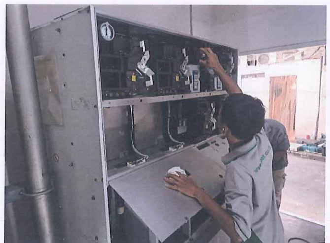
ภาพชุดที่ 1 ขณะดำเนินการตรวจสอบและทำความสะอาดรักษาสภาพภายในตู้ไฟฟ้าแรงสูง ไม่พบร่องรอยรั่วไหลทางไฟฟ้าที่อาจก่อให้เกิดการ Break down
