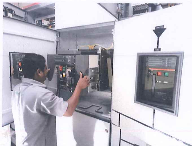
ภาพชุดที่ 9 ขณะดำเนินการเช็คทำความสะอาดทั่วไปของ Air Circuit Breaker
