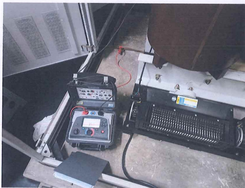
ภาพชุดที่ 5 ขณะดำเนินการตรวจสอบสภาพฉนวนของหม้อแปลงไฟฟ้า ด้วยวิธีการ Polarization Index เพื่อเป็นข้อมูลติดตามในปีต่อไป
