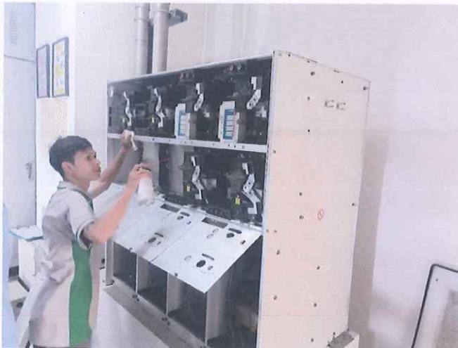
ภาพชุดที่ 1 ขณะดำเนินการตรวจสอบและทำความสะอาดรักษาสภาพภายในตู้ไฟฟ้าแรงสูง ไม่พบร่องรอยรั่วไหลทางไฟฟ้าที่อาจก่อให้เกิดการ Break down
