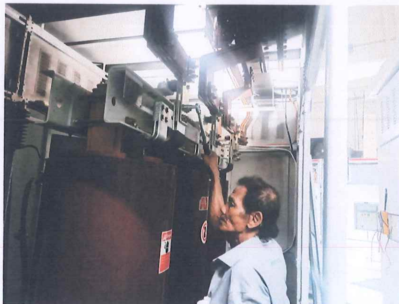
ภาพชุดที่ 4 ขณะดำเนินการกดขันน็อตภายในหม้อแปลงไฟฟ้า เพื่อป้องกันการคลายตัว
